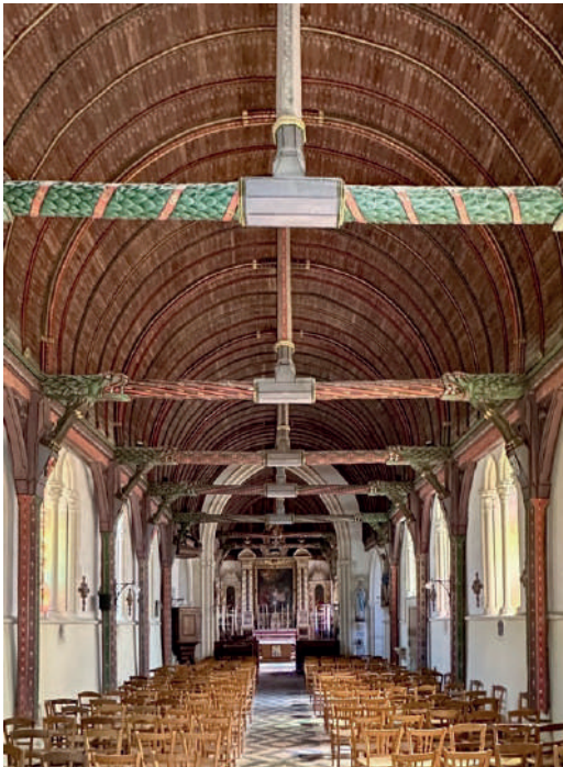
Église du Mesnil-sur-Blangy, la nef, la voûte en merrain et les entrails sculptés de rageurs
